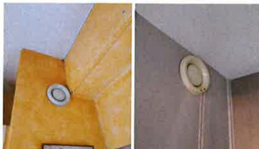
*Exemple de bouches d'extraction d'air de VMC dans les pièces humides des logements*
