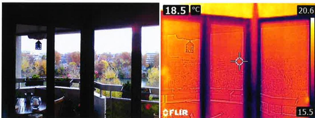
**Intérieur d'un logement /** Faiblesse thermique important aux niveaux des châssis des menuiseries. En effet les châssis sont aluminium et sont dépourvus de rupteur de ponts thermiques. La couleur sombre de la structure des menuiseries traduit des déperditions thermiques importantes.
