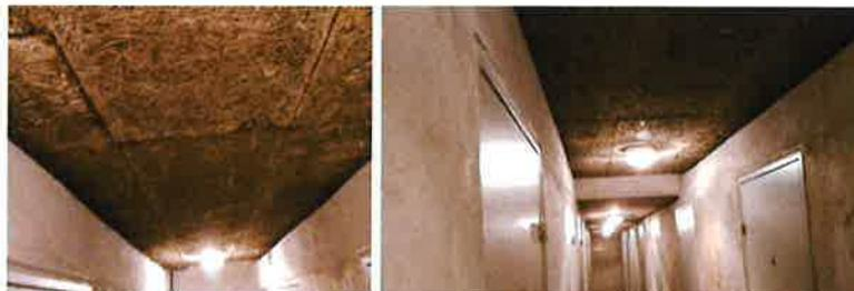
Vue inférieure sur le plancher bas / Le plancher bas qui donne sur les caves est isolé avec 7 cm de fibralith. Les déperditions thermiques au travers de cette paroi sont donc réduites.
