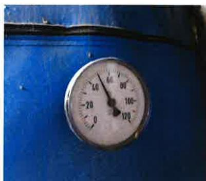
**Santé / La température réglementaire pour éviter la prolifération de la légionellose dans l'ECS est de 55°C sur les ballons d'ECS. Certains ballons d'ECS sont chauffés à une température inférieure**
