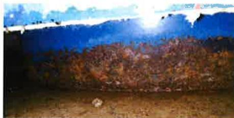
Vue la base d'un ballon d'ECS corrodé
