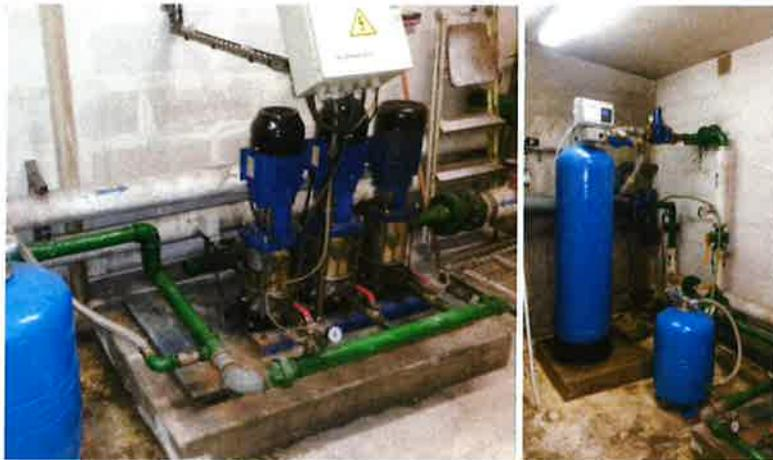
**Local traitement de l'eau /** La photo à gauche montre, la partie surpression de l'installation. La photo de droite montre la partie traitement d'eau de l'installation.
