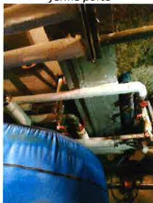
**Sécurité / Absence de flocage CF 2 heure, sur le plafond des locaux chaufferies**
