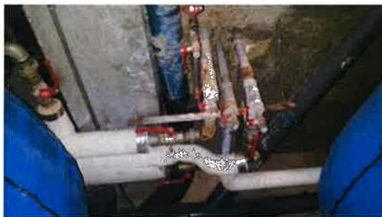
**Réseau / Corrosion importante au niveau du réseau de distribution d'eau chaude sanitaire.**
