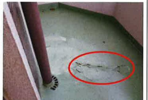
Infiltration d'eau sous le revêtement du plancher d'un balcon
