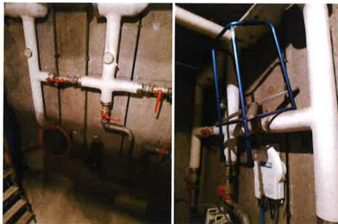
**Chaufferies /** Plusieurs tronçons de conduite ne sont pas utilisés dans les chaufferies, comme le montre les vannes fermées sur les photographies. Cette configuration augmente le risque de prolifération de légionelloses et les pertes de charge dans le réseau de distribution.
