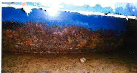
**Fuite d'eau / Fuite importante dans la chaufferie du bâtiment B entré 15 et corrosion importante au niveau des pieds de ballons d'ECS**
